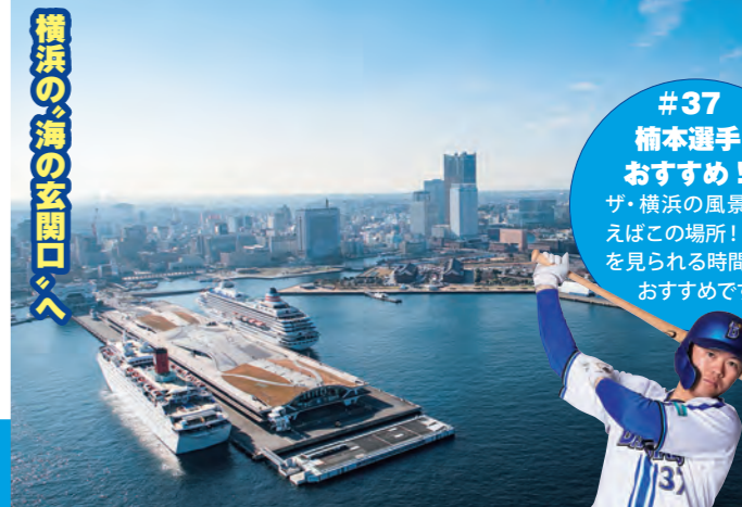
長さ430m、幅70mを誇る巨大な棧橋
