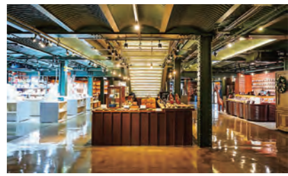
日本最古の荷役用エレベーターが設置された建物
