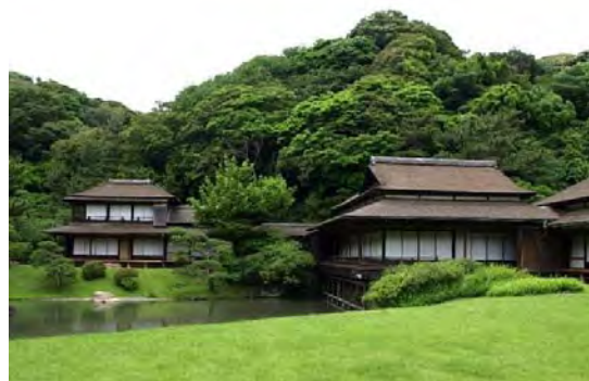
【大規模修繕対象施設 臨春閣(重要文化財)】
