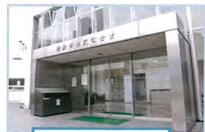
金沢公会堂 外観
