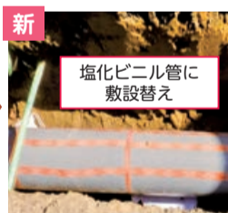
下水道再整備工事
