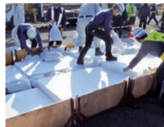
(一社)横浜建設業協会金沢区会と連携した道路段差解消訓練
