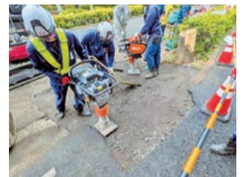
道路の緊急補修
