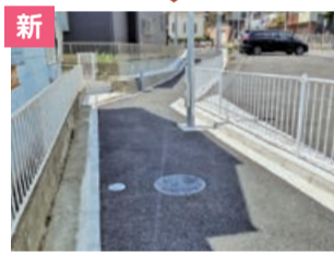
釜利谷地区の歩道改良工事(水路敷を歩道に整備)
