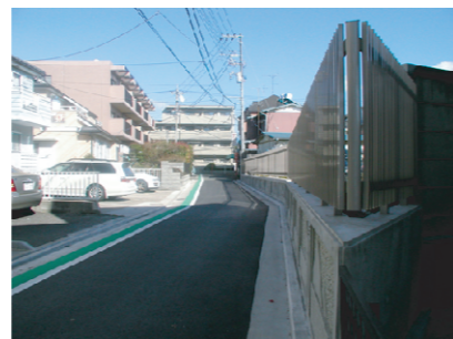
いえ・みち まち改善事業による道路拡幅と歩行者通行路側帯のカラー舗装化
