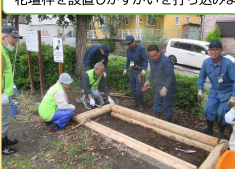
花壇枠を設置しかすがいを打ち込みます
