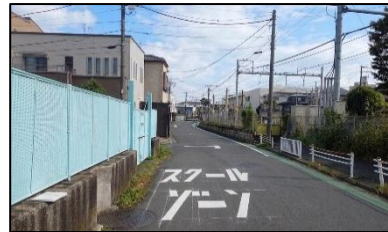
通学路 路面標示の補修
