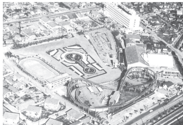
開園当時の反町公園(昭和38年頃) 出典:「横浜の公園」(横浜市中央図書館所蔵)
