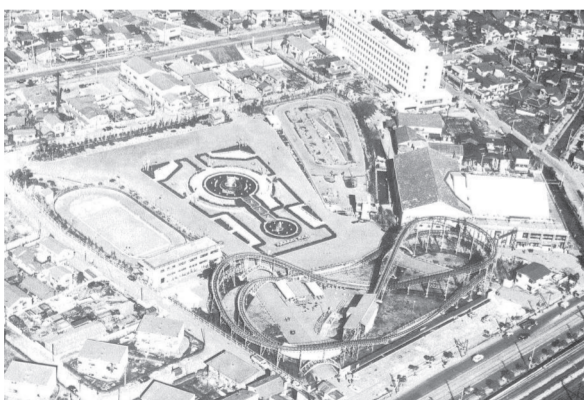
開園当時の反町公園(昭和38年頃) 出典:『横浜の公園』(横浜市中心図書館所蔵)
