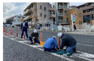
<道路の施設修繕>
