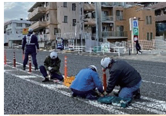
道路の施設修繕
