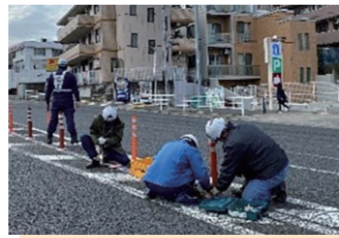
道路の施設修繕
