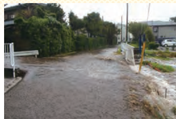
上飯田町の道路冠水 (平成26年10月 台風18号)
