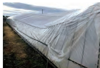
泉区内農家の暴風被害 (令和元年9月 台風15号)
