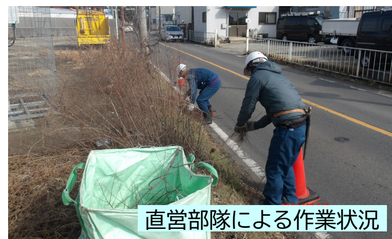
直営部隊による作業状況
