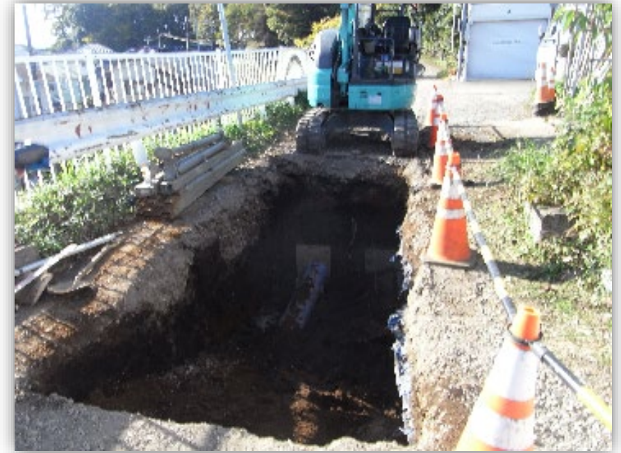
下水道管布設状況
