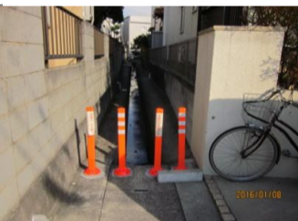
進入防護柵設置
