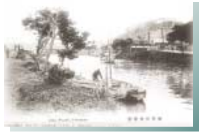
初期の根岸の掘削と開削後の中村の切り通し(右奥)。
