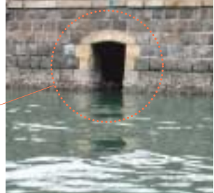
▲石積と排水口。
