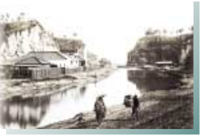
堀割川開削の難所「中村切り通し」の当時の様子。
