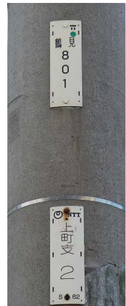
東京電力も使用しているNTT柱
