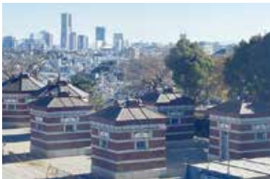
西谷浄水場内歴史的建造物
