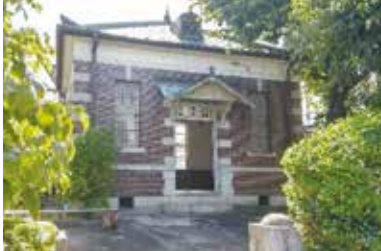
川島町旧配水計量器室上屋
