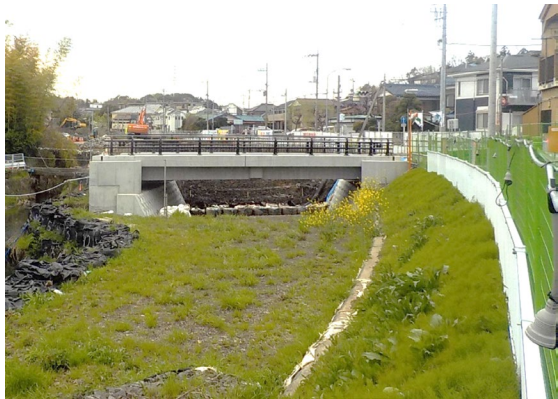
【帷子川流域における河道掘削・護岸整備・橋梁架替え（整備例）】
