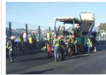
道路修繕工事（舗装補修工事）
