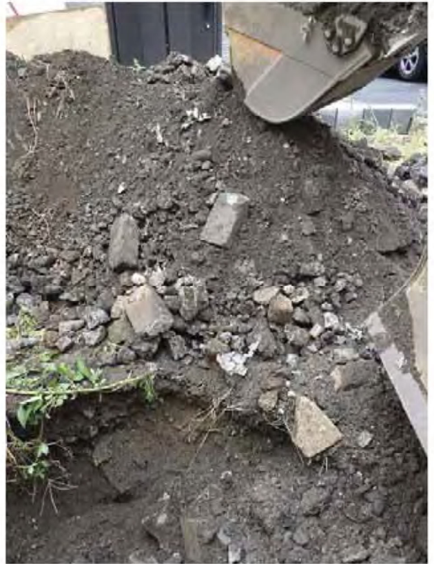
掘削土砂②
