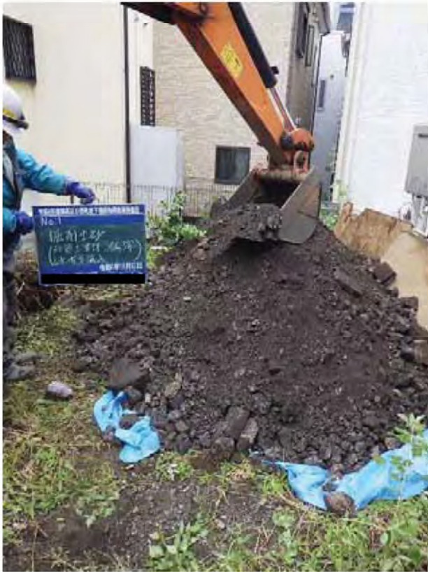
掘削土砂①
