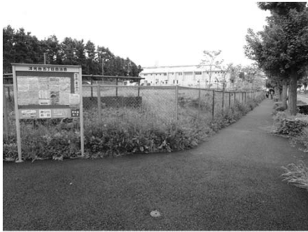
現況写真 (敷地北西側から撮影)
