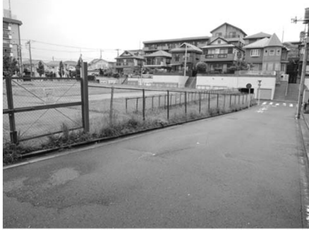
現況写真 (敷地南東側から撮影)
