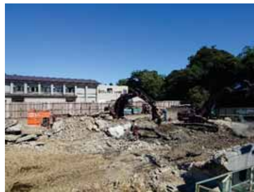
体育館・プール棟解体写真
