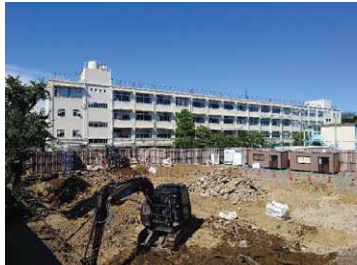
体育館・プール棟解体風景
