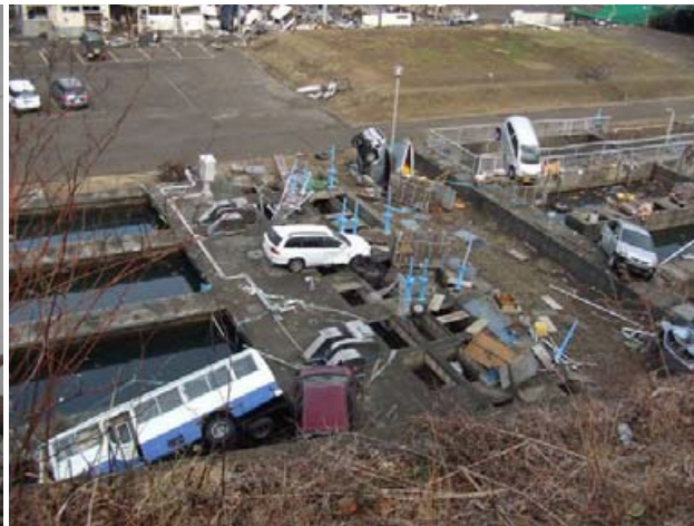
写真4. 下水処理場における津波被害の代表事例
