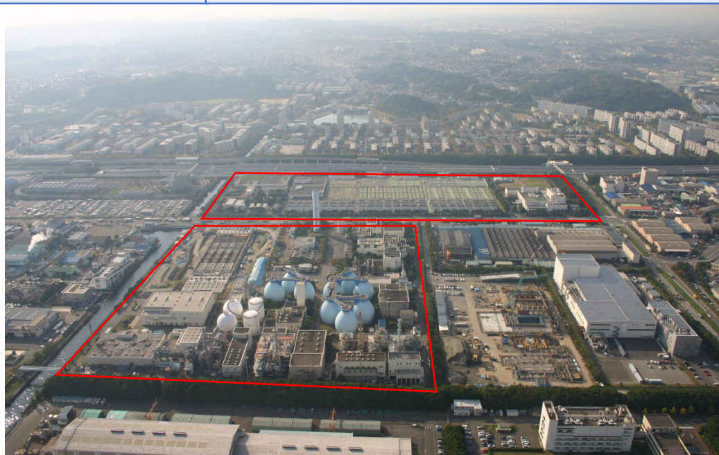
写真1. 南部下水道センター航空写真
