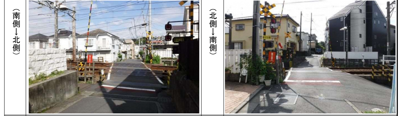
①西谷3号踏切 ~住宅地内の生活道路の踏切。
