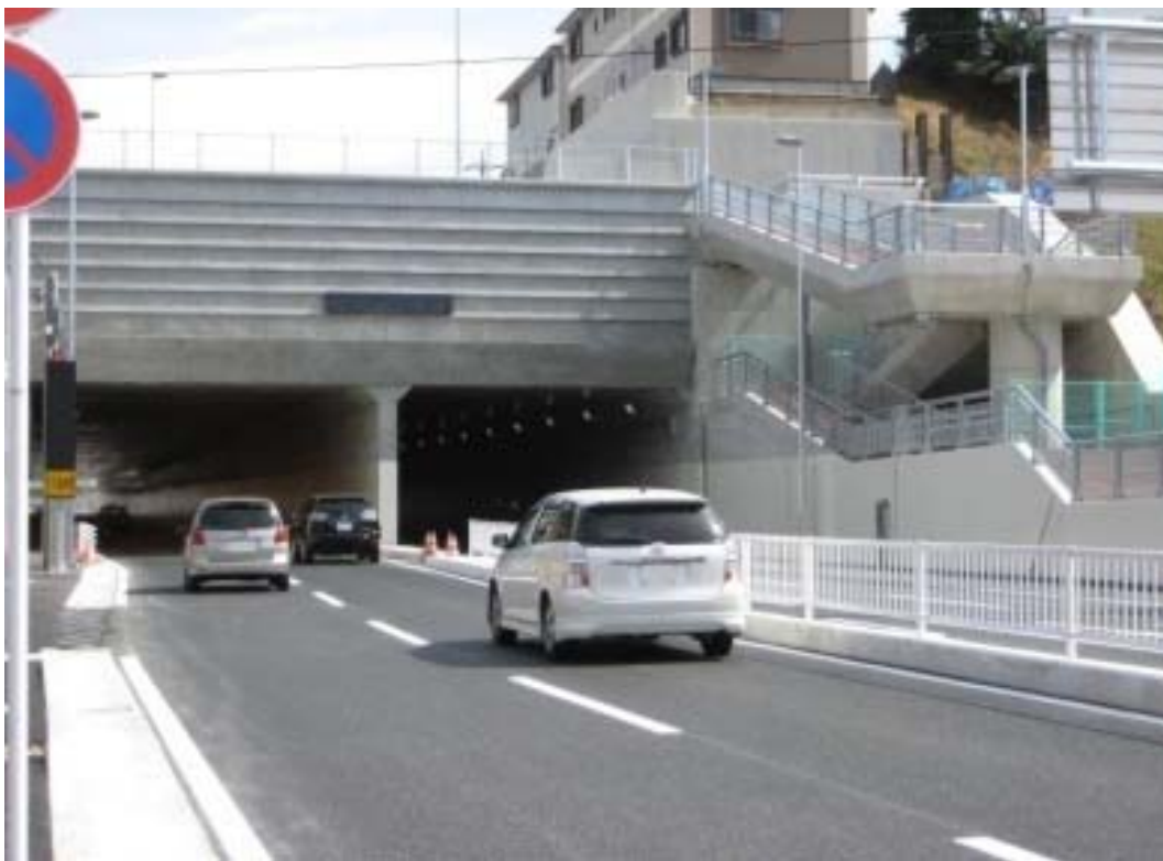
写真① 西側地区 白鴨トンネル坑口(緑営業所側)
