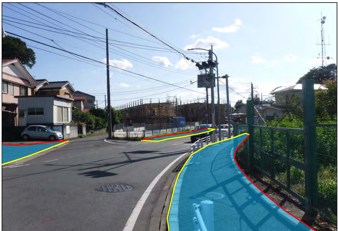
県道青砥上星川(上菅田地区)道路改良事業 写真⑧
