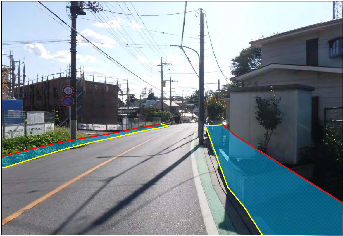
県道青砥上星川(上菅田地区)道路改良事業 写真⑨
