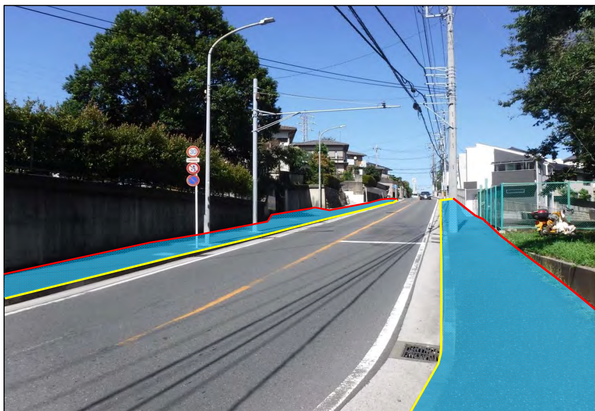
県道青砥上星川(上菅田地区)道路改良事業 写真④
