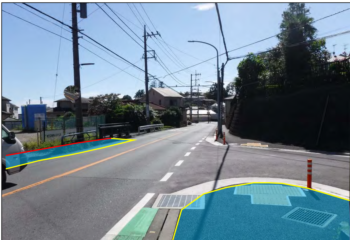
県道青砥上星川(上菅田地区)道路改良事業 写真⑩
