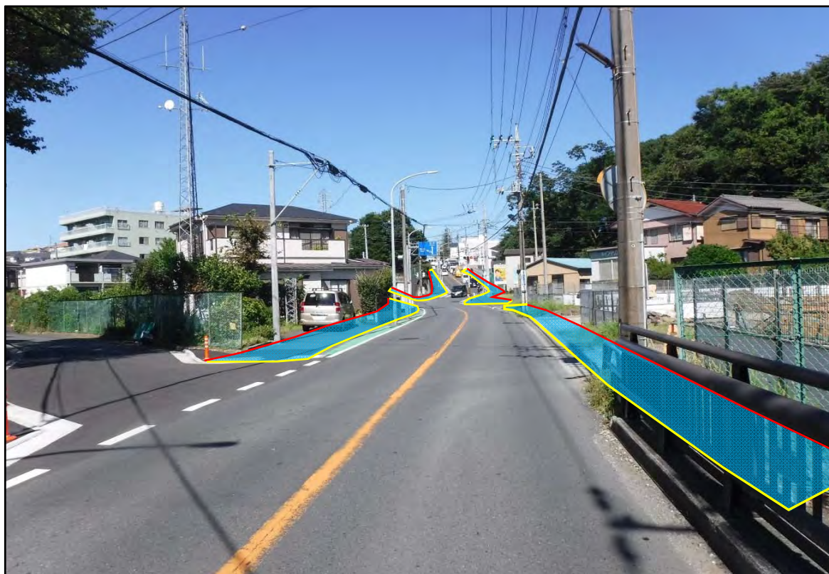
県道青砥上星川(上菅田地区)道路改良事業 写真①
