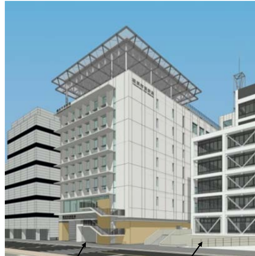
消防本部庁舎
