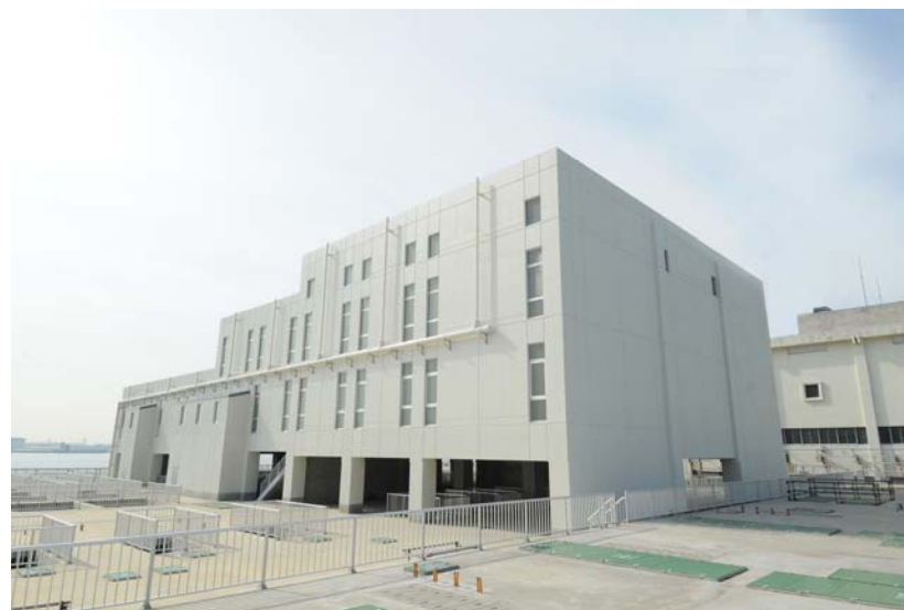
新処理系列建築躯体
