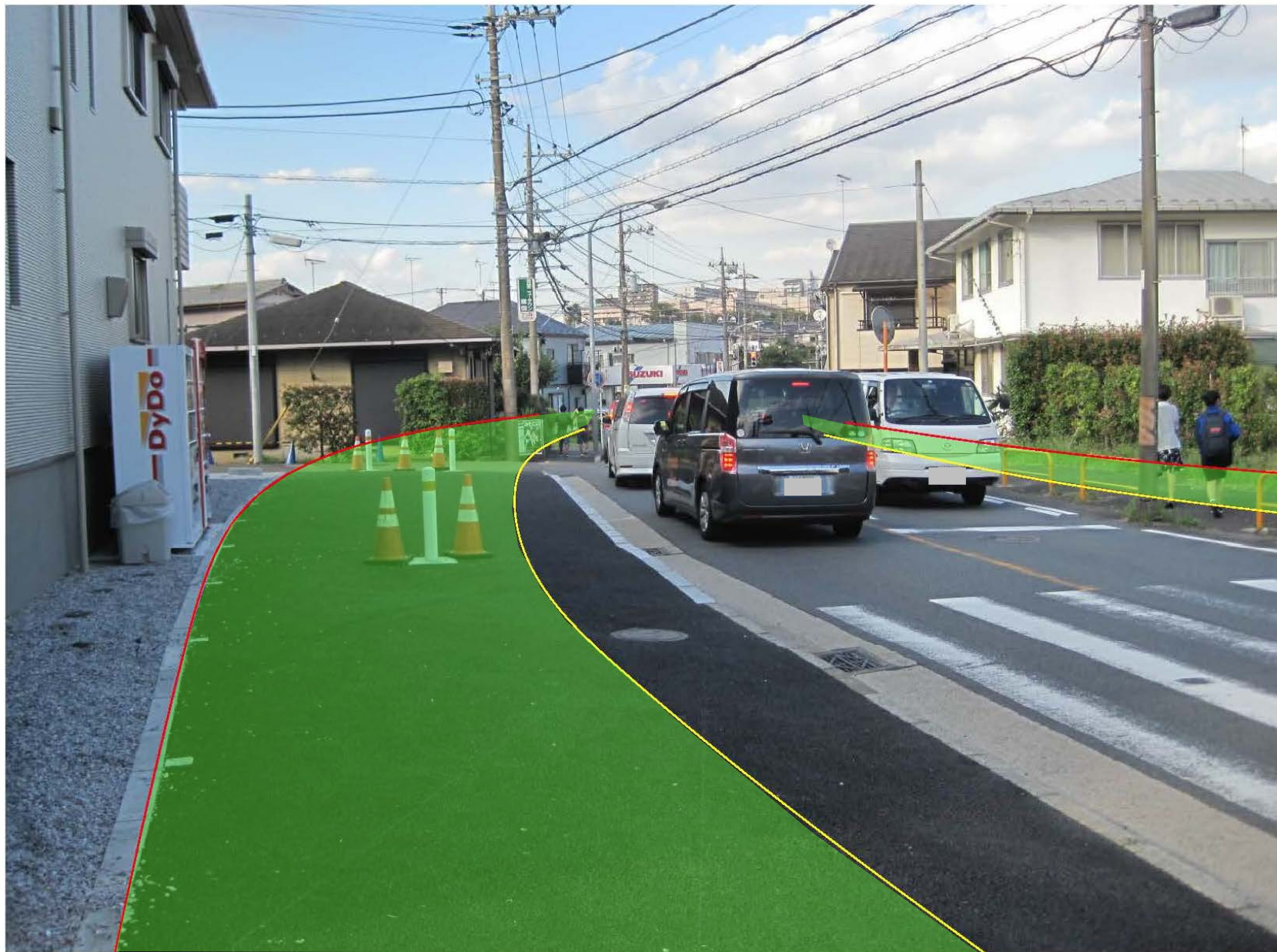
主要地方道横浜生田（柚の木交差点）改良事業 写真⑦
