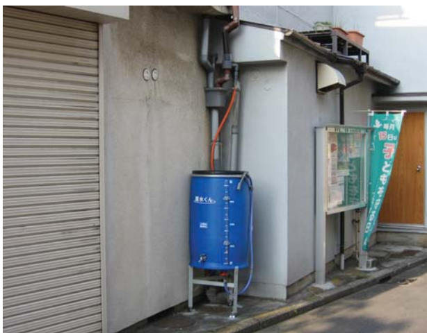
【雨水タンク整備】
