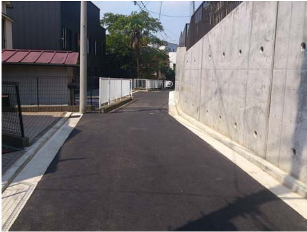
【道路整備 拡幅 60m】
