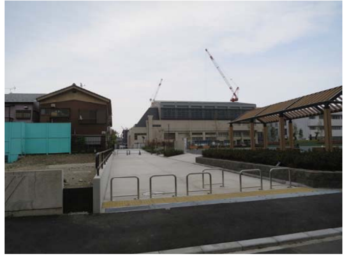
鶴工跡地通り抜け通路整備（西側）※
