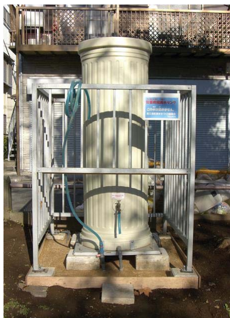
雨水タンク設置
