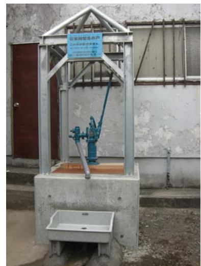
【井戸ポンプ整備】
