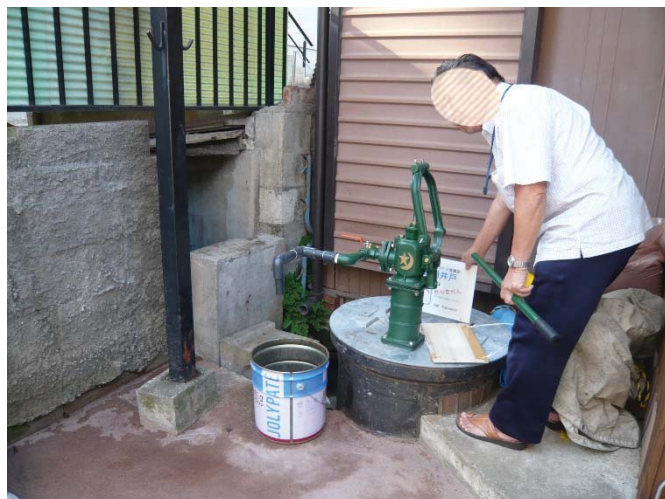
井戸ポンプ整備
