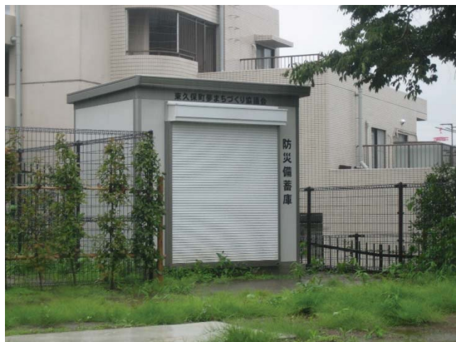
防災備蓄倉庫設置 (緑地内)
