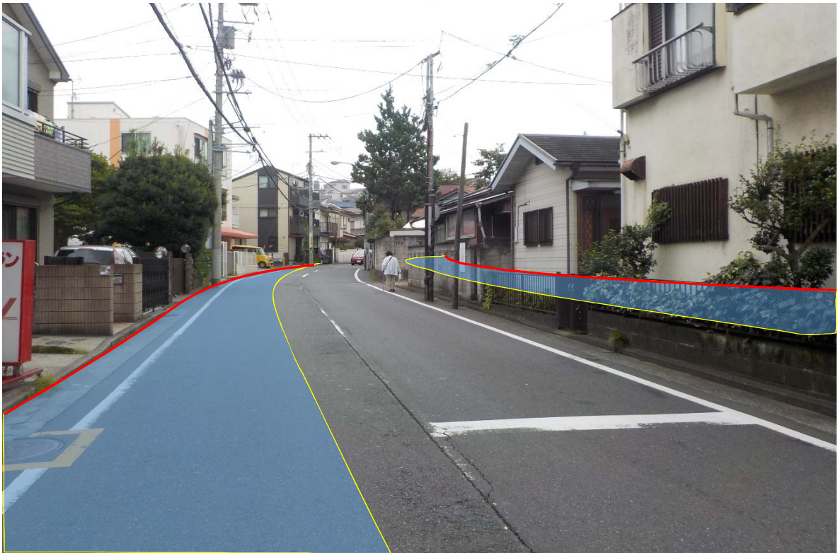
市道上大岡第149・168号線道路改良事業 写真②
