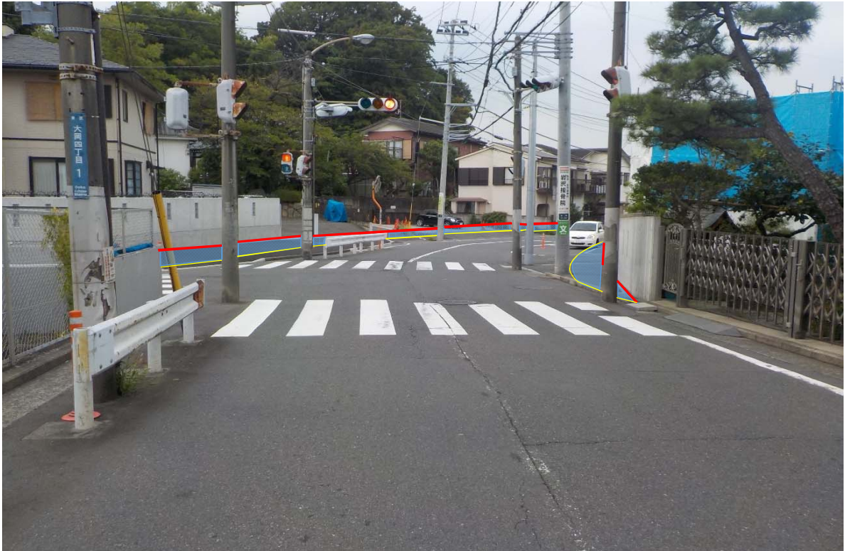
市道上大岡第149・168号線道路改良事業 写真⑤
