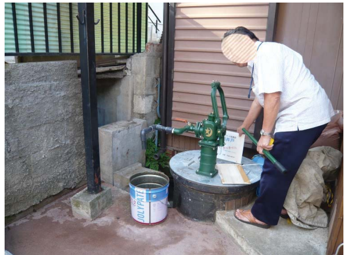
井戸ポンプ整備
