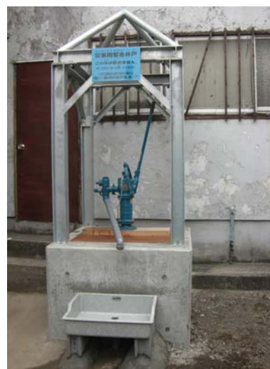
【井戸ポンプ整備】
