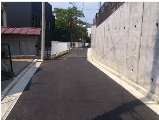
【道路整備 拡幅 60m】
