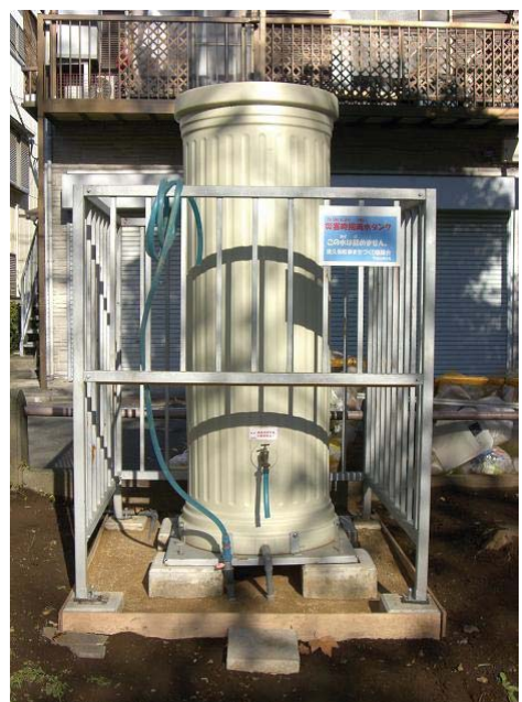
雨水タンク設置
