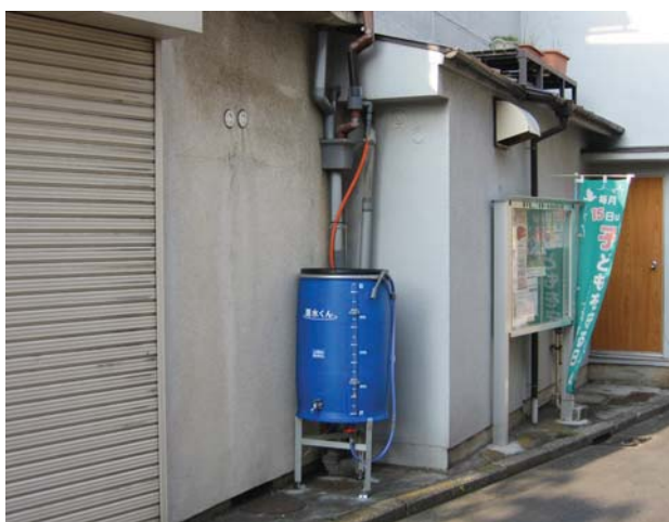
【雨水タンク整備】
