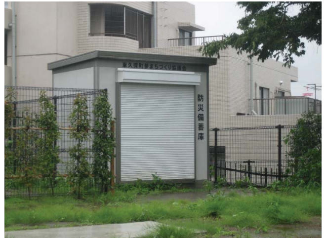
防災備蓄倉庫設置 (緑地内)
