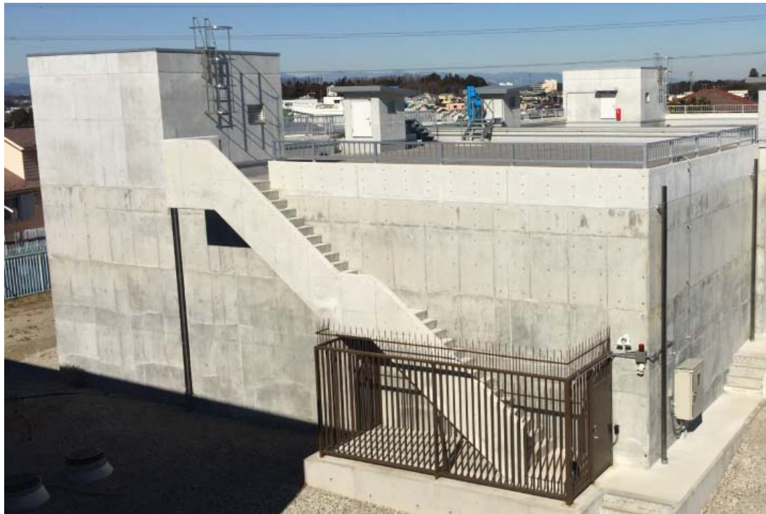
【図4】鶴ヶ峰2号配水池（外観）
