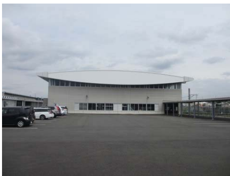
検修庫等施設増築
