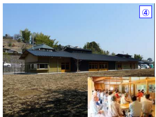
里山資源循環作業舎（つどいの家）、体験広場
