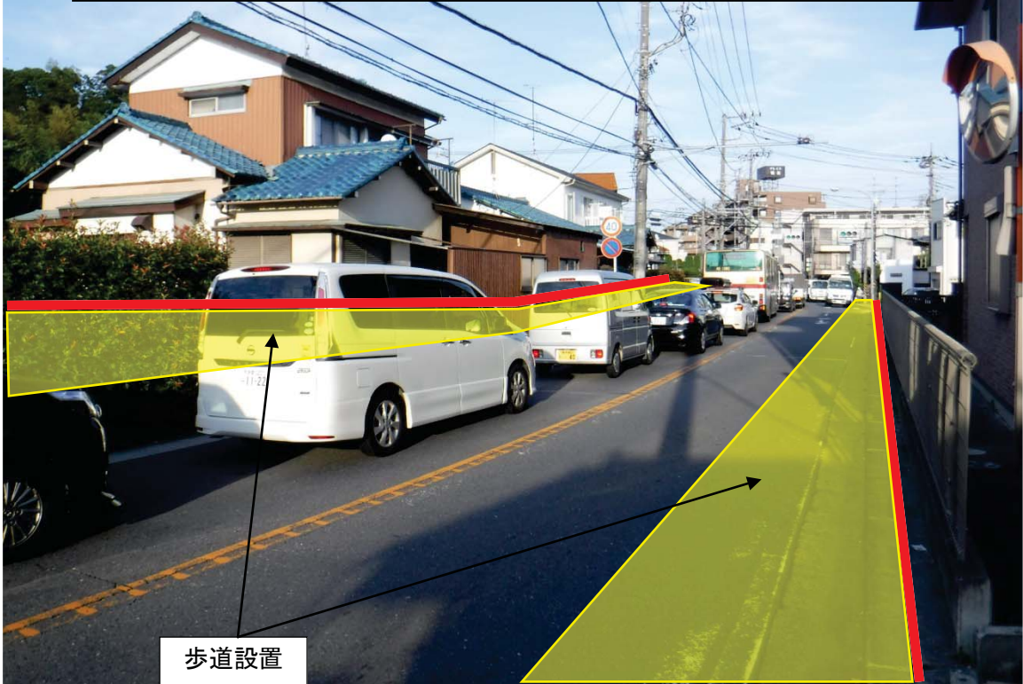
写真③ 主要地方道横浜上麻生(佐江戸その2地区)
