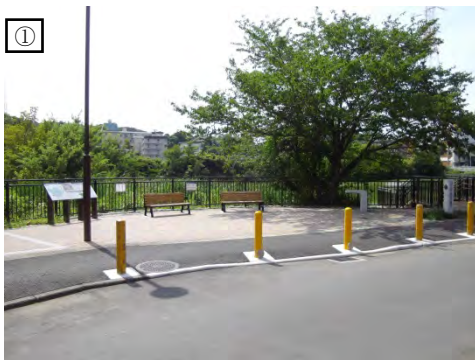
整備済みのエントランス部分
