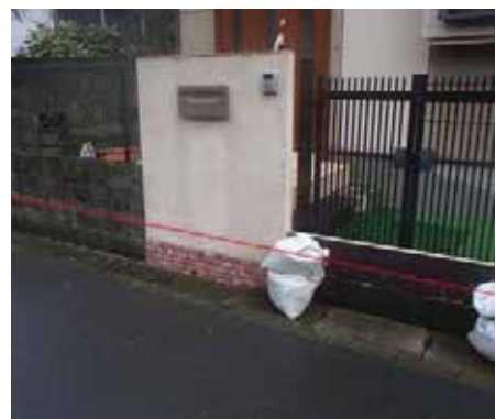
平成 26 年 10 月 6 日の台風 18 号により相沢南公園付近の道路が冠水（赤線の位置まで水位が上昇）
