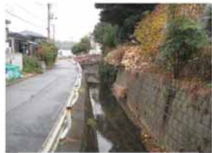
大面川雨水幹線現況写真
