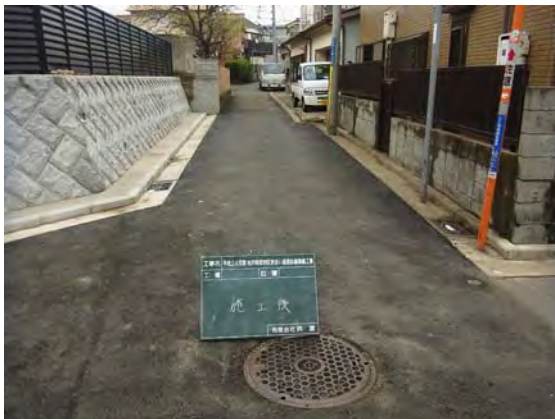
道路整備 拡幅 37m
