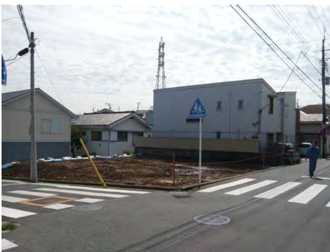
建替促進助成 (除却後)
