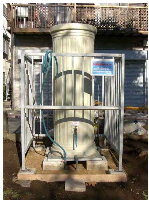
雨水タンク整備
