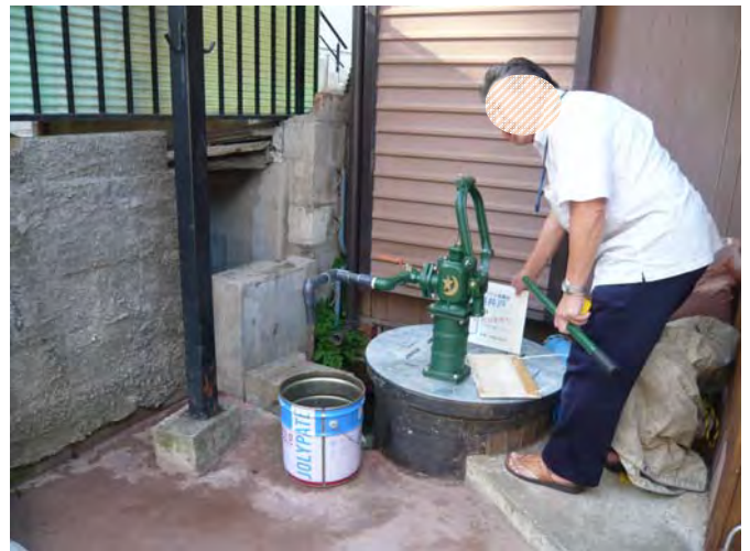
井戸ポンプ整備
