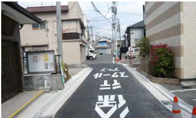
道路整備 拡幅 625m
