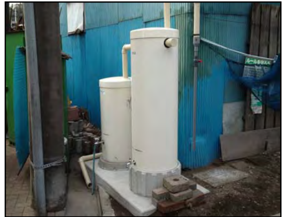
雨水タンク整備 (3000) 1箇所
