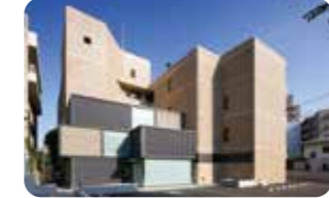
西区にある“横浜市民ギャラリー”。市の研修・宿泊施設だった旧いせやま会館を改修し、市民ギャラリーにリノベーション。
