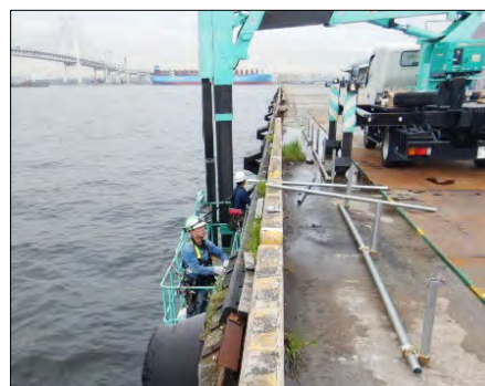
【岸壁補修工事】
