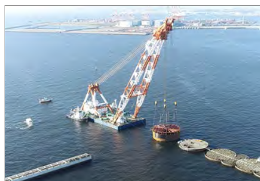
【鋼板セルの設置状況】
