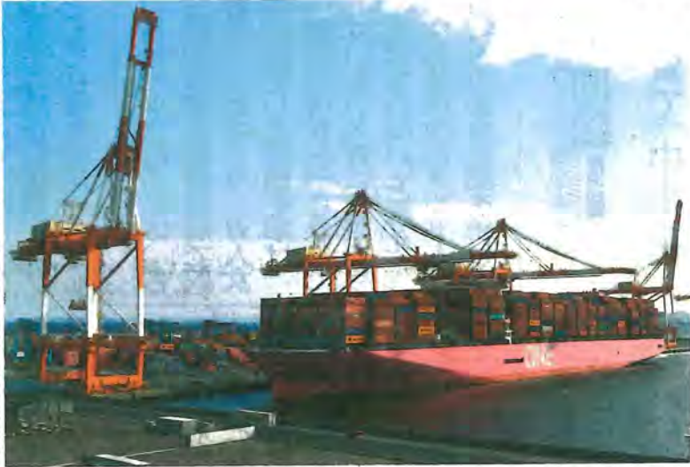
世界最大級のコンテナ船の接岸が可能な横浜港の南本牧ふ頭 || 横浜市中区
