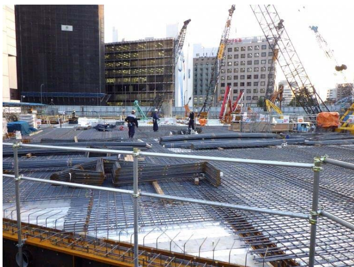
1) デッキプレート敷き込み、配筋
