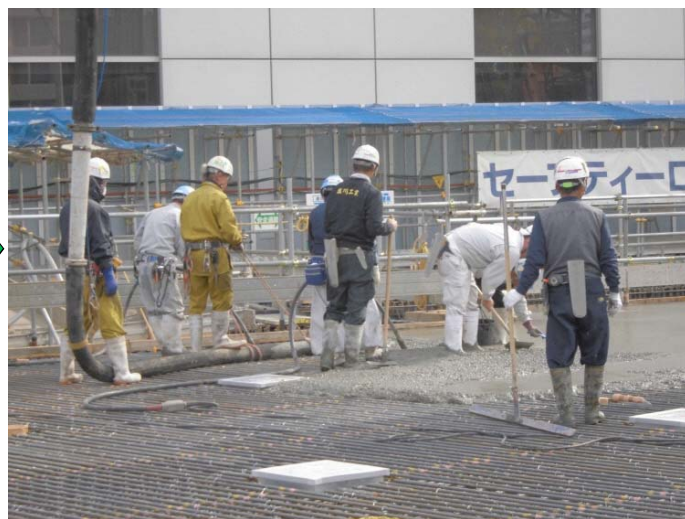
2) コンクリート打設
