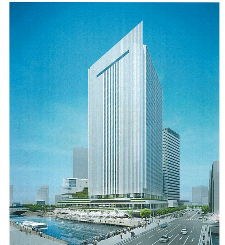
弁天橋方面からの外観
