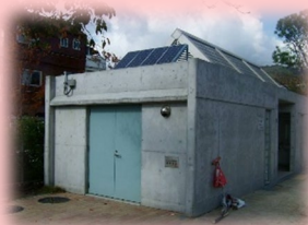
倉庫付き災害用トイレ
