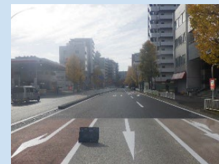
寿町周辺地区の道路整備
