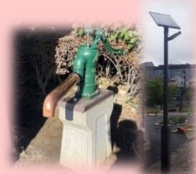
防災井戸・ソーラー電源
