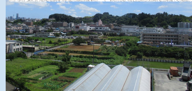
施行検討区域（写真奥が小机駅）
