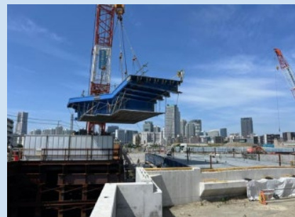
橋梁架設の様子
