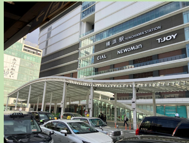
▲横浜駅中央西口駅前広場：多くの来街者を迎え入れる玄関口にふさわしいにぎわいのある空間を創出するため、舗装工事や、エリマネ活動に活用可能な設備（電気トラフ等）を整備
