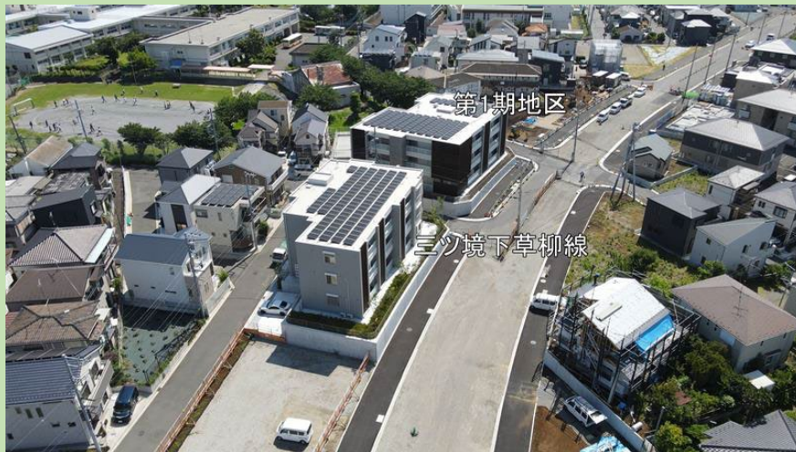
▲二ツ橋北部地区第1期地区：横浜グリーンエクスポへの来場者を輸送するシャトルバスのルートとして想定されている道路を整備
