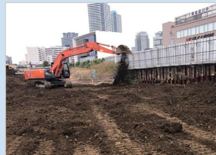
埋立工事の様子
