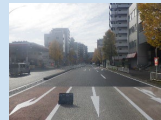
寿町周辺地区の道路整備
