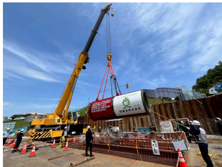
水道管更新工事(シールド工事)
